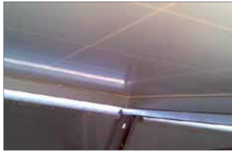
Durch die neigbare Objektiveneinheit der Wärmebildkamera FLIR T335 kann Danny Kerremans Wärmebilder von der Rückseite der Module aufnehmen und vermeidet damit falsche "heiße Stellen", die durch Spiegelungen entstehen.
