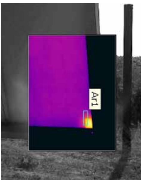
Dieses Bild-im-Bild zeigt eine heiße Zelle, Grund dafür ist ein Schatten des Alarmsystems in der Nähe.
