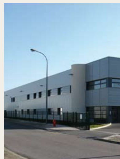
Der Hauptgeschäftssitz und das Ausbesserungswerk von CEAT Electronique in Longvic, Frankreich
